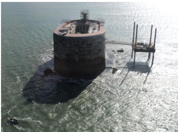
Les années à venir devraient voir le **remplacement de la plate-forme d'accès off-shore** qui montre des états avancés de corrosion des tôles des caissons, **l'amélioration de la plate-forme d'hélicoptage** et les **travaux éventuels de restauration des pierres de taille**.
